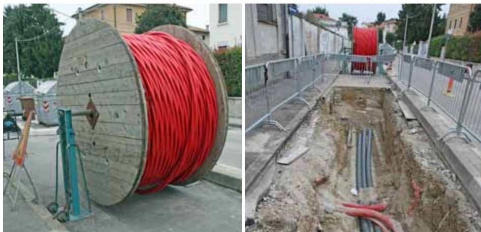
Des chantiers de cette nature ont fleuri dans de nombreuses villes d'Europe pour passer les nouveaux câbles
