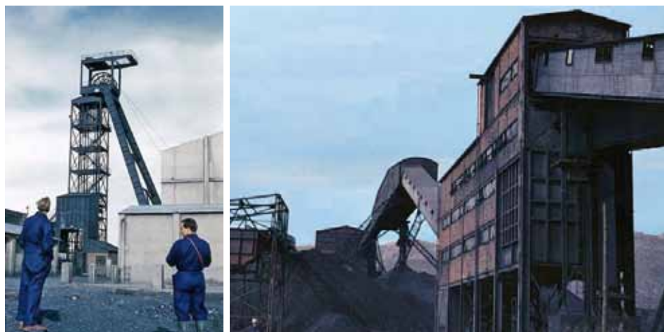
Chevalement et autres installations d'exploitation de la mine d'anthracite de Jerada, aujourd'hui à l'abandon
