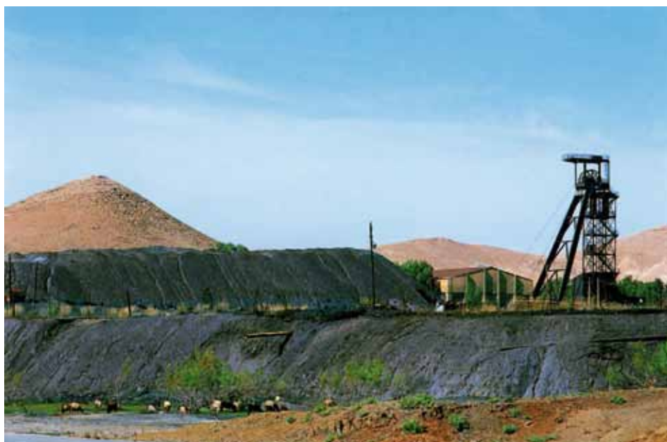
Le site désormais à l'abandon du Puits 1 de l'ancienne mine d'antracite, attenant à la ville de Jerada
