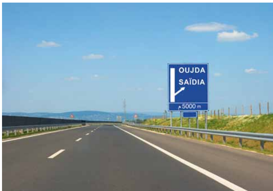
La nouvelle autoroute Fès-Oujda
