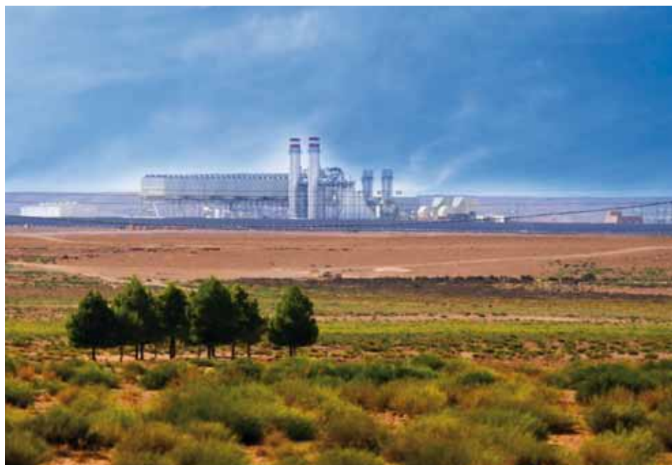
La centrale thermo-solaire de Aïn-Bni-Mathar
