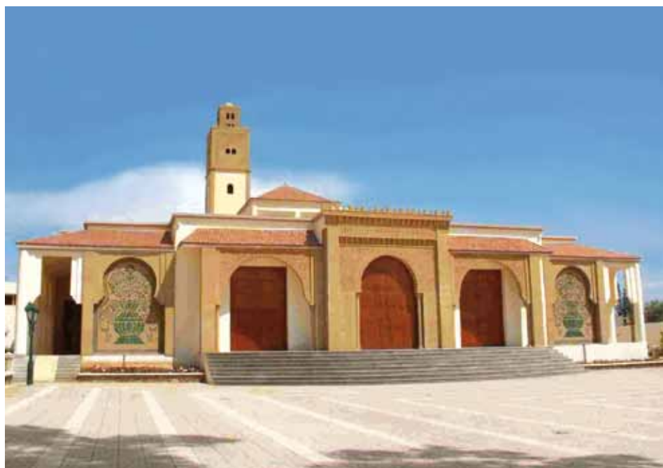
La nouvelle grande mosquée de Jerada, complément naturel de la mise à niveau des mosquées de la Province
