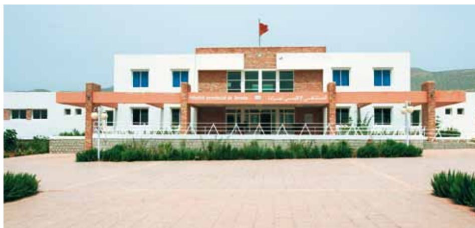
Le nouvel hopital provincial de Jerada, au coeur du dispositif de santé à rénover
