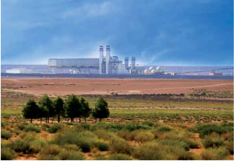
المحطة الحرارية الشمسية لعين بني مطهر
